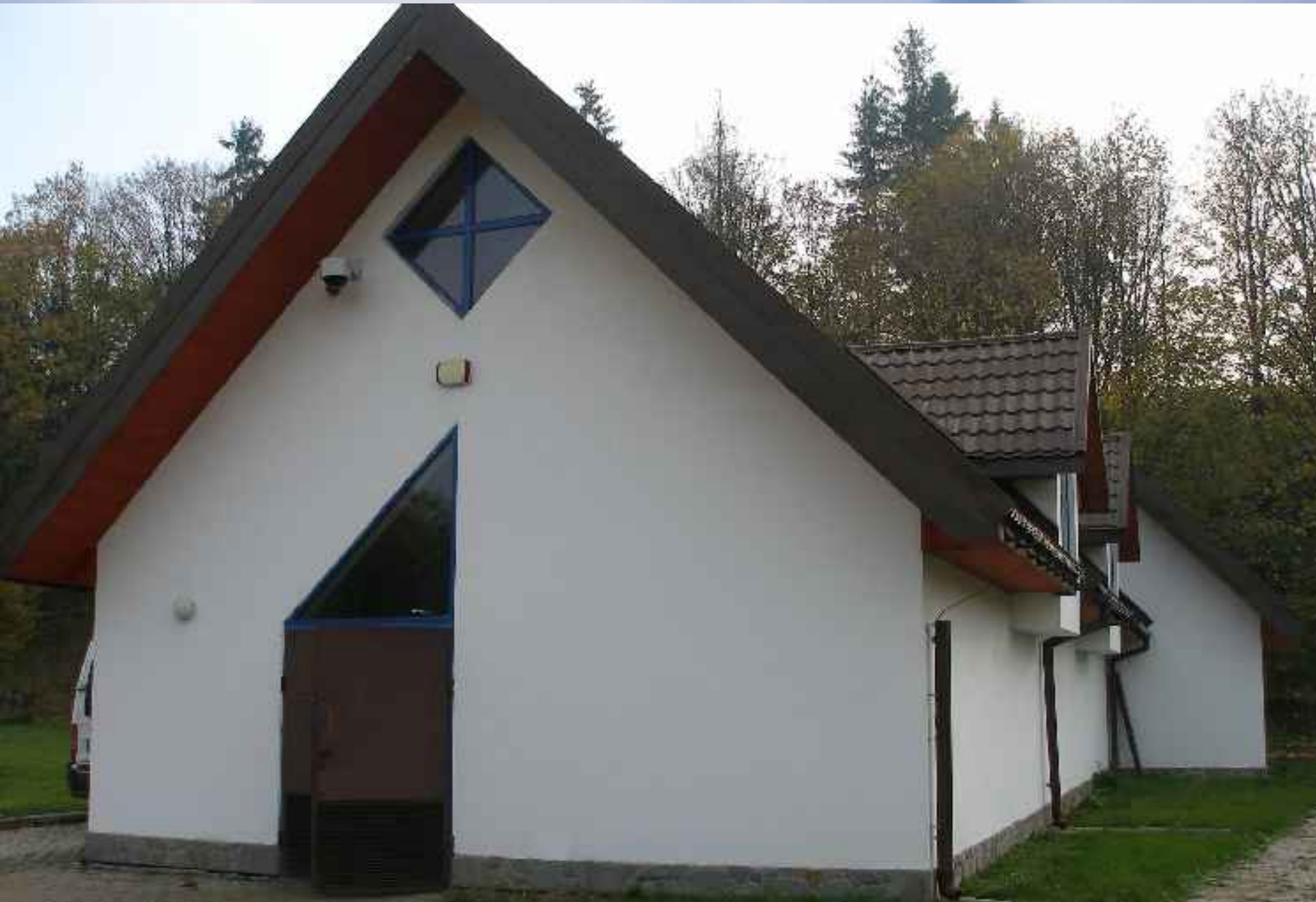
Pompownia Geotermalna Biały Dunajec
