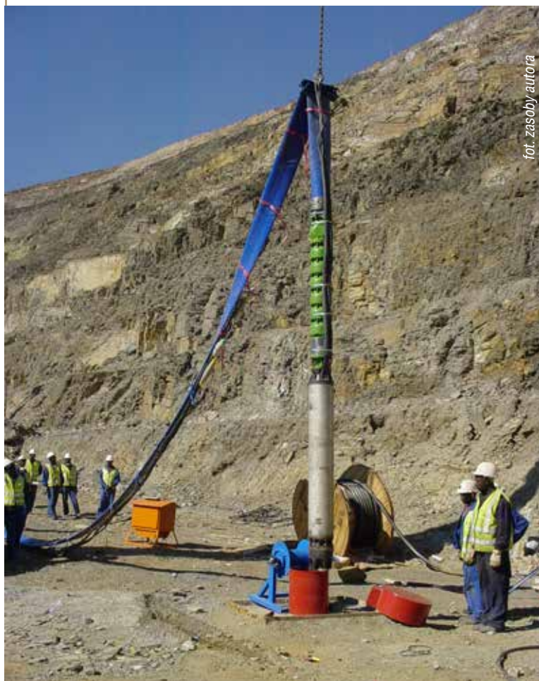
FOT. 1 Montaż przewodów elastycznych w studniach
