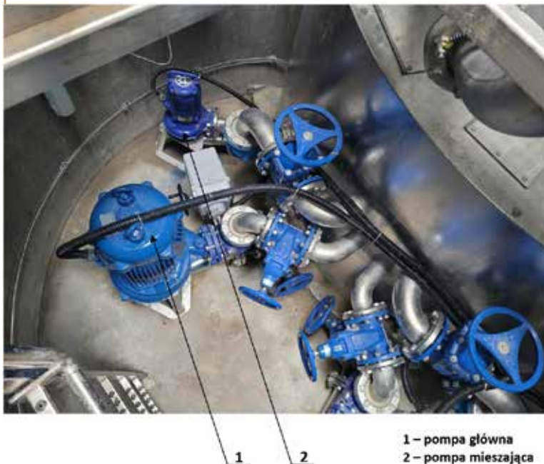
FOT. 2 Tłocznia ścieków TSC z układem by-pass
