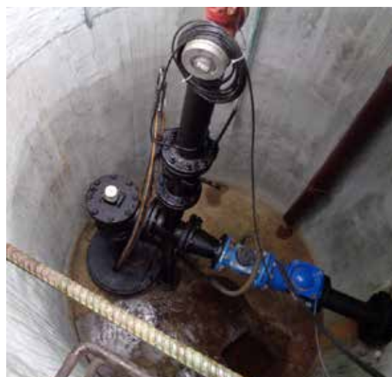
FOT. 1 Głowica studni S5
