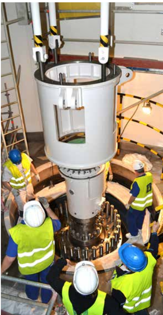
EMO34, WYSPA JĄDROWA, GCN-317, główna pompa cyrkulacyjna chłodzenia reaktora, montaż
