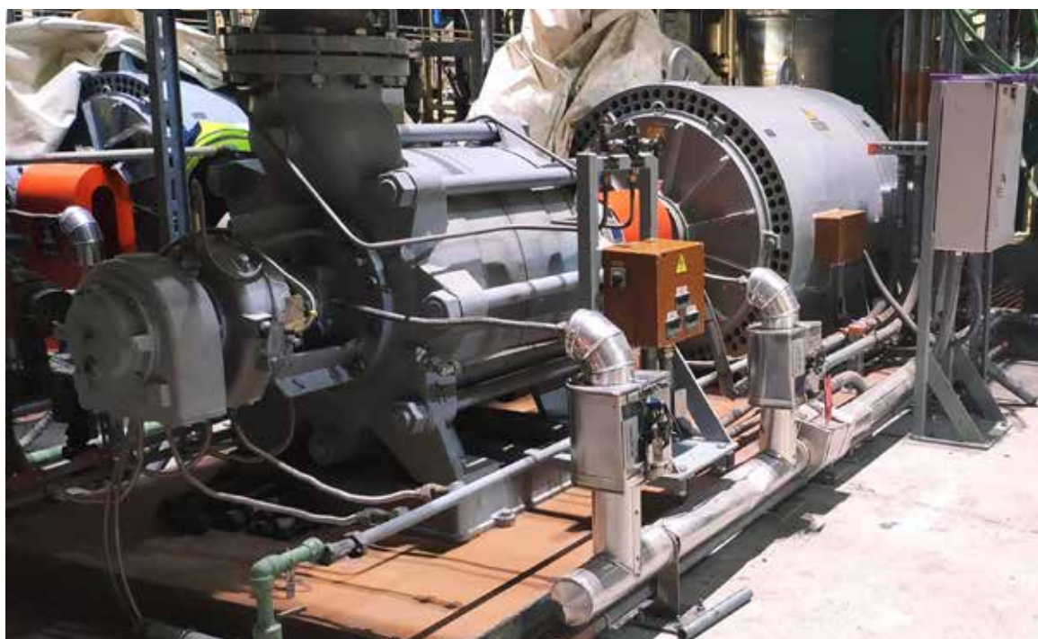
EMO34, WYSPA TURBINOWA, 250-CVN- 460, pompa kondensatu drugiego stopnia, montaż
