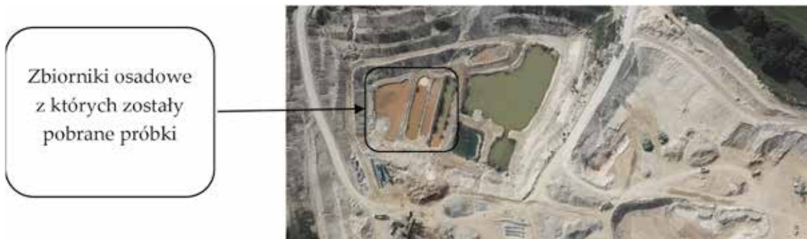
FOT. 1 Złoże kruszyw naturalnych wraz ze zbiornikami osadowymi, Pomellen-Nord, Niemcy
