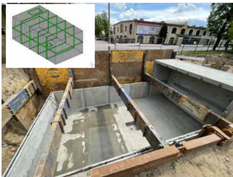
RYS. 2 Prace montażowe (źródło: zasoby własne autora)
