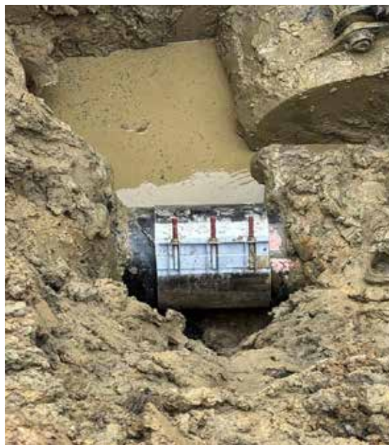
FOT. 3 Awaria sieci wodociągowej, montaż opaski naprawczej (źródło: opracowanie własne Wodociągi Chrzanowskie Sp. z o.o.)
